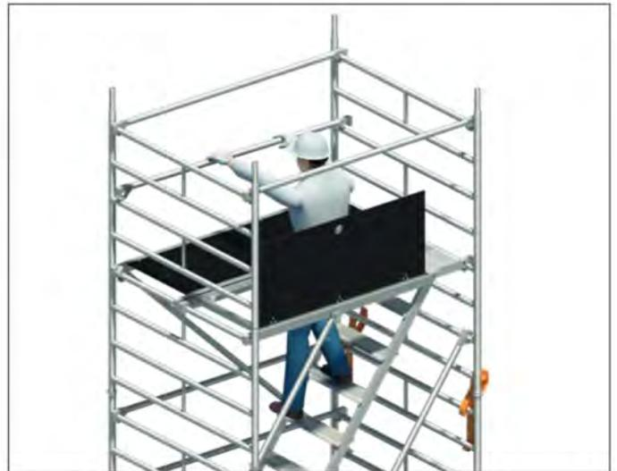
3. Abstieg über die Stufen der Podesttreppe 8 durch die dafür vorgesehene Durchstiegsklappe. In der Durchstiegsöffnung, auf der Treppe stehend, absturzgesichert durch die Holme der Treppendurchstiegsbrücke 10 erfolgt die Demontage der Zwischengeländer in 0,5m Höhe über der Plattform.
