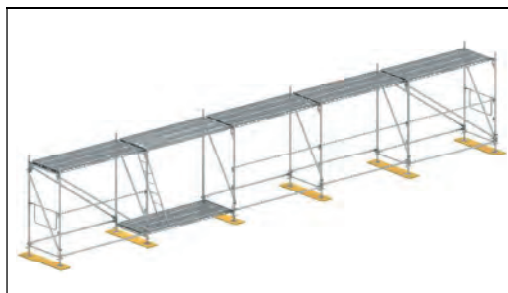
Bild 2-24: Montierte unterste Lage
