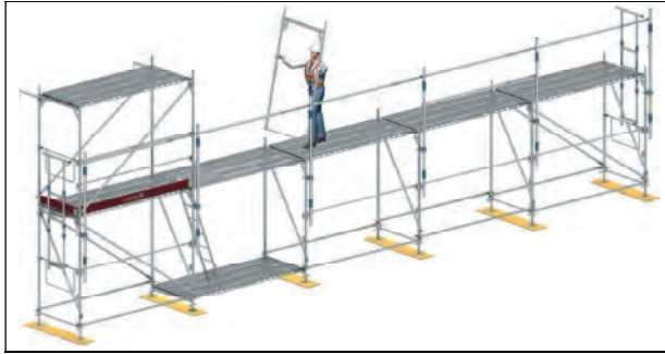
Bild 2-26: Montage der Gerüstfelder
