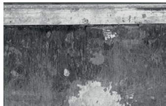
Bild 1-5: „durchgefäult“
